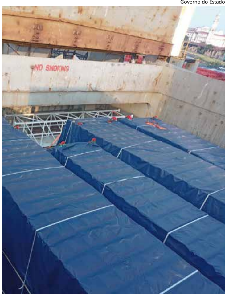
Tatução está sendo montado em canteiro na Vila Carrão, para agilizar as obras de expansão da Linha 2 - Verde
