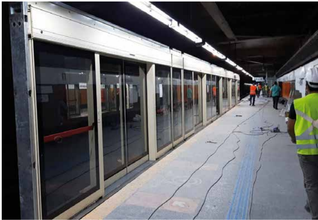
Obras da estação Jabaquara começaram em dezembro do ano passado
