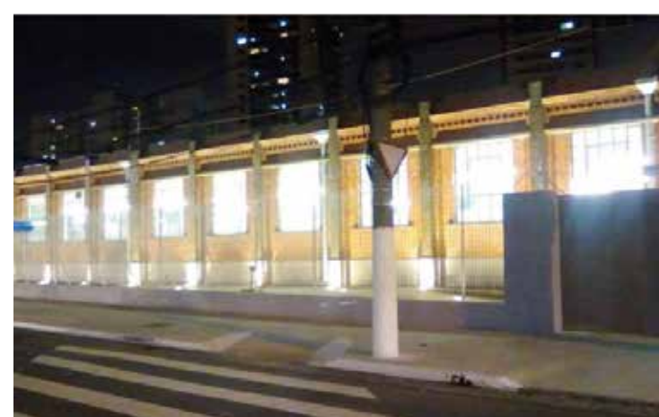
A modernização da subestação Vila Mariana da Enel foi uma das obras executadas com promessa de melhoria no sistema
